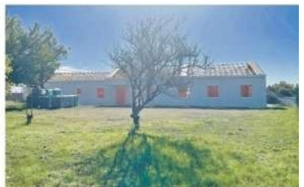
Les travaux ont démarré au mois d'avril dernier. ©C.D.
